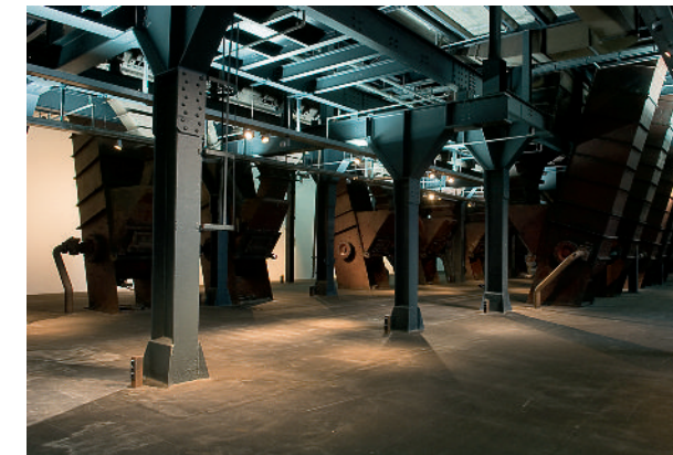
Le concept d'éclairage des zones d'exposition de la laverie de charbon de la mine Zollverein à Essen (Allemagne) combine un éclairage indirect et fluorescent blanc lumière du jour au plafond et les accents chauds de projecteurs à lampes halogènes basse tension.
