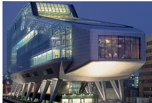
Des sources lumineuses aux différentes températures de couleur permettent souvent, dans les immeubles de bureau tels que le siège de la banque ING à Amsterdam, d'isoler les espaces de représentation.
