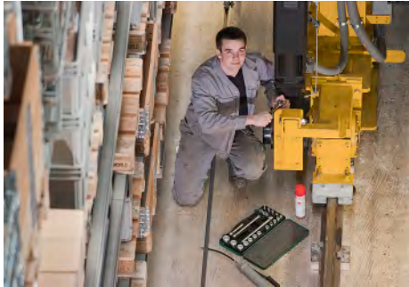
Wartung des Fahrtriebes eines Regalbediengerätes im Hochregallager.
