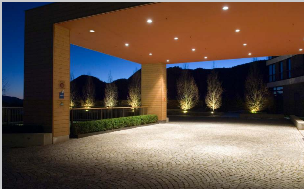
Intercontinental Resort, Berchtes- gaden. Architekt: Kochta Architek- ten, München. Elektroplanung: Ingenieurbüro Schnell, Tuttlin- gen.
