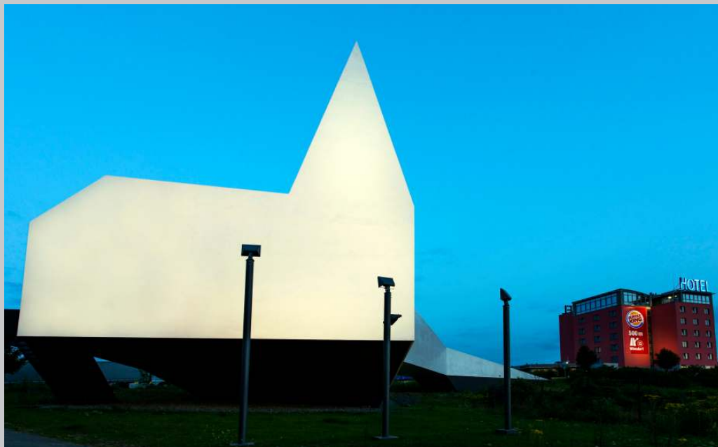
Église d'auto- route Siegerland, Wilnsdorf. Archi- tecture : schnei- der + schumacher, Francfort-sur-le- Main. Photogra- phie : Dirk Vogel, Altena.
