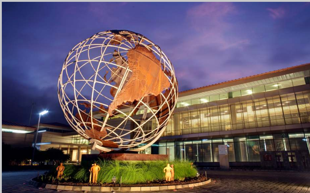
Suzlon One Earth Campus, Pune. Architectuur: CCBA, Tao Archi- tects, Ravi & Varsha Govandi. Lichtplanning: Sathish Rana. Fotografie: Swapan Parekh.
