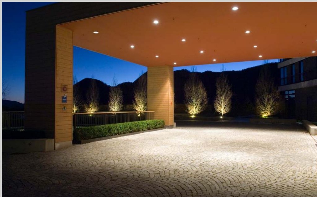
Intercontinental Resort, Berchtes- gaden. Architect: Kochta Architek- ten, Munich. Electrical design: Ingenieurbüro Schnell, Tuttlin- gen.
