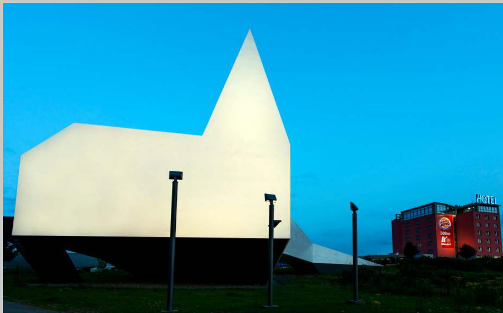
Autobahnkirche Siegerland, Wilns- dorf. Architektur: schneider + schu- macher, Frankfurt am Main. Foto- grafie: Dirk Vogel, Altena.
