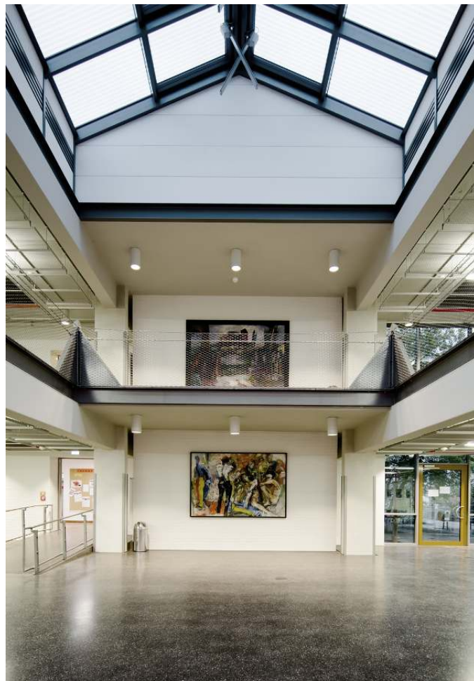
Hogeschool Neu- brandenburg, Leergebouw 4, Neubranden- burg/Duitsland. Architectuur: A&S GmbH Neu- brandenburg. Lichtplanning: NEIB - Neubran- denburger Elektro- Ingenieur-Büro GmbH. Installatie: EIM GmbH Elek- tro-Installation- Montage, Greifs- wald. Fotografie: Frieder Blickle, Hamburg.
