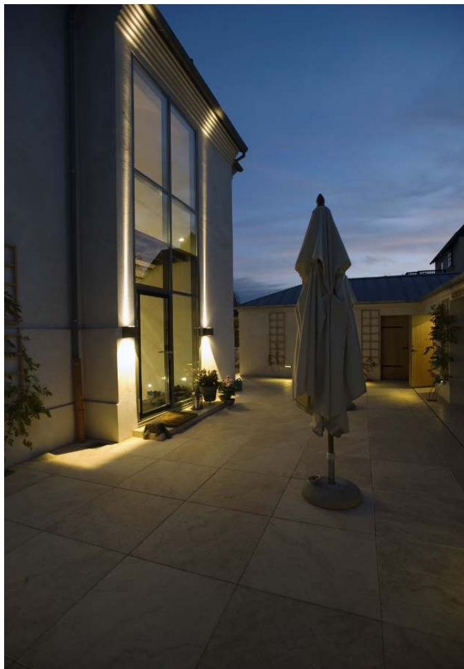
Privathaus, Esper- gærde. Architekt: Dall Lindhardtzen, Helsingør. Elek- troplaning: OGC Building Consul- tants, Bagsværd. Fotografie: Rudi Meisel, Berlin.
