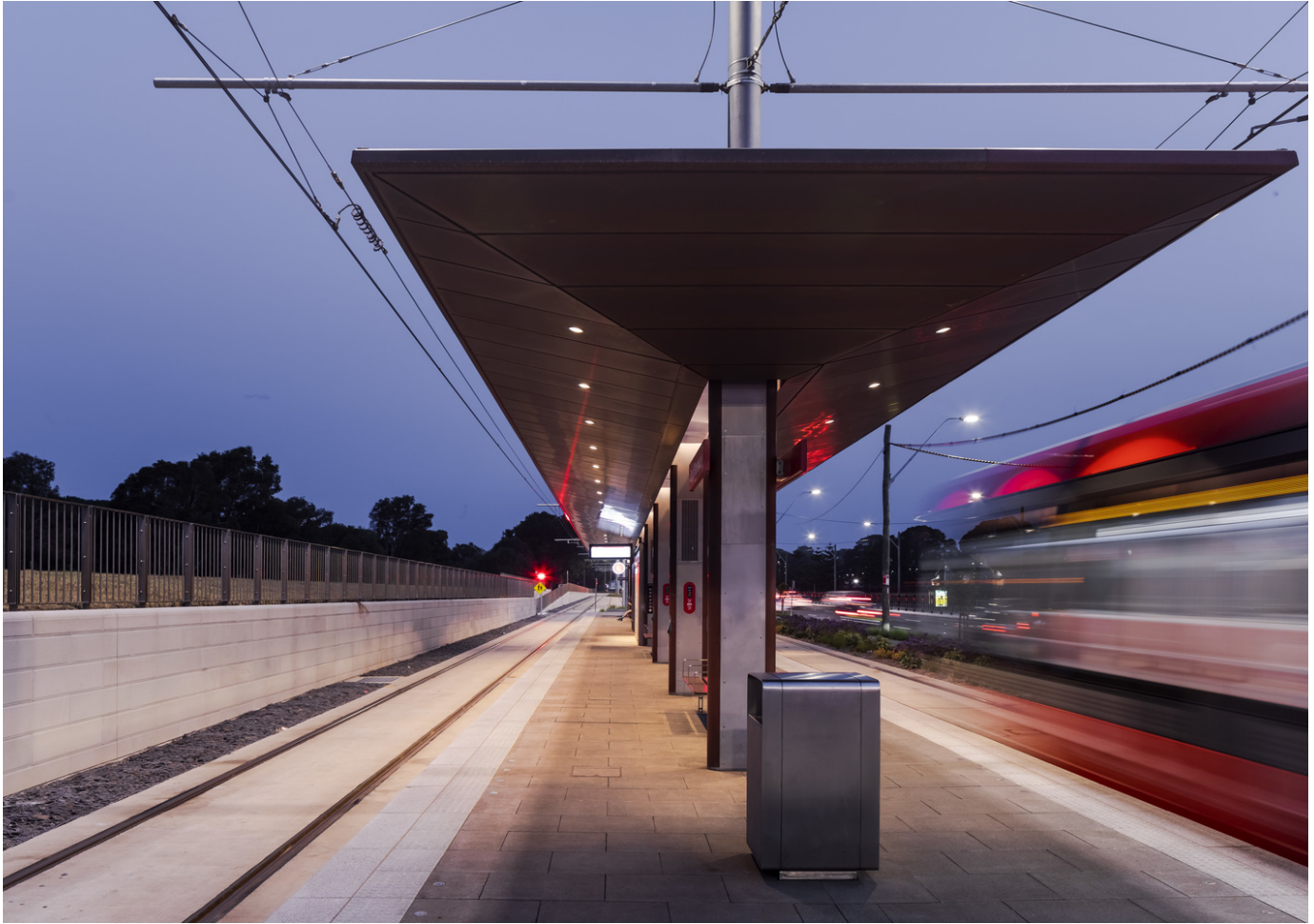
Metro Ligero de Sídney, Sídney. Arquitectura: Grimshaw. Diseño de iluminación: Electrolight, Sídney. Fotografía: Jackie Chan, Sídney.
