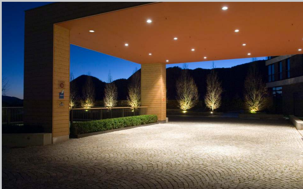
Intercontinental Resort, Berchtes- gaden. Architecte : Kochta Architekten, Munich. Concep- tion électrique : Ingenieurbüro Schnell, Tuttlin- gen.
