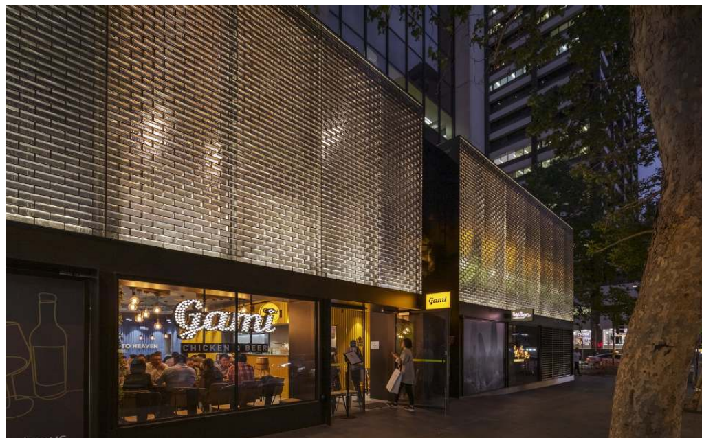
Facciata in mattonelle per vetrocemento 44 Market, Syd- ney. Architettura: Woods Bagot. Fotografia: Jackie Chan, Sidney.
