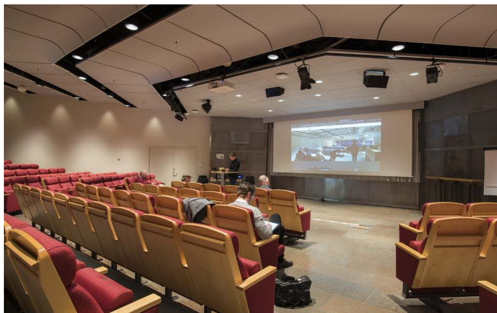
Hemeryksalen nel Centro congressi e concerti Louis de Geer, Norrköping. Progettazione illuminotecnica: Ramboll. Instal- lazione: Bravida. Fotografia: Johan Elm, Stoccolma.
