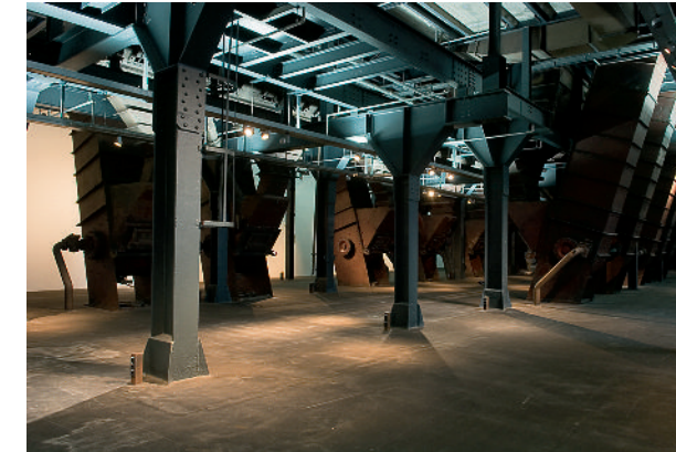
Il concetto dell'illuminazione delle superfici espositive della laveria di carbone della miniera di Zollverein di Essen combina la luce delle lampade fluorescenti dal colore bianco da luce diurna, impiegate per l'illuminazione indiretta tramite la riflessione sul soffitto, con gli accenti dalle tonalità calde dei faretto per lampade alogene a bassa tensione.
